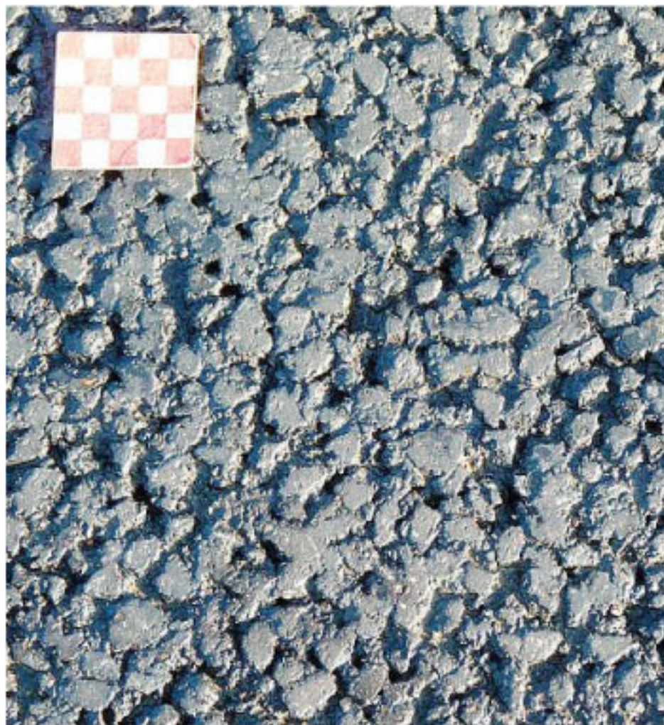
Con la pioggia l'asfalto drenante riduce drasticamente gli incidenti
